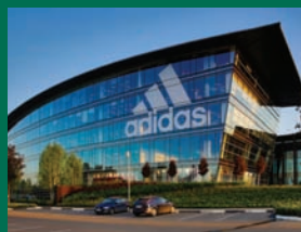
БЦ Крылатские холмы, ул. Крылатская
